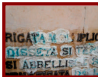
Pulitura lettere in metallo mediante solventi applicati ad impacco
