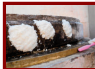
Pulitura materiale lapideo mediante solventi
